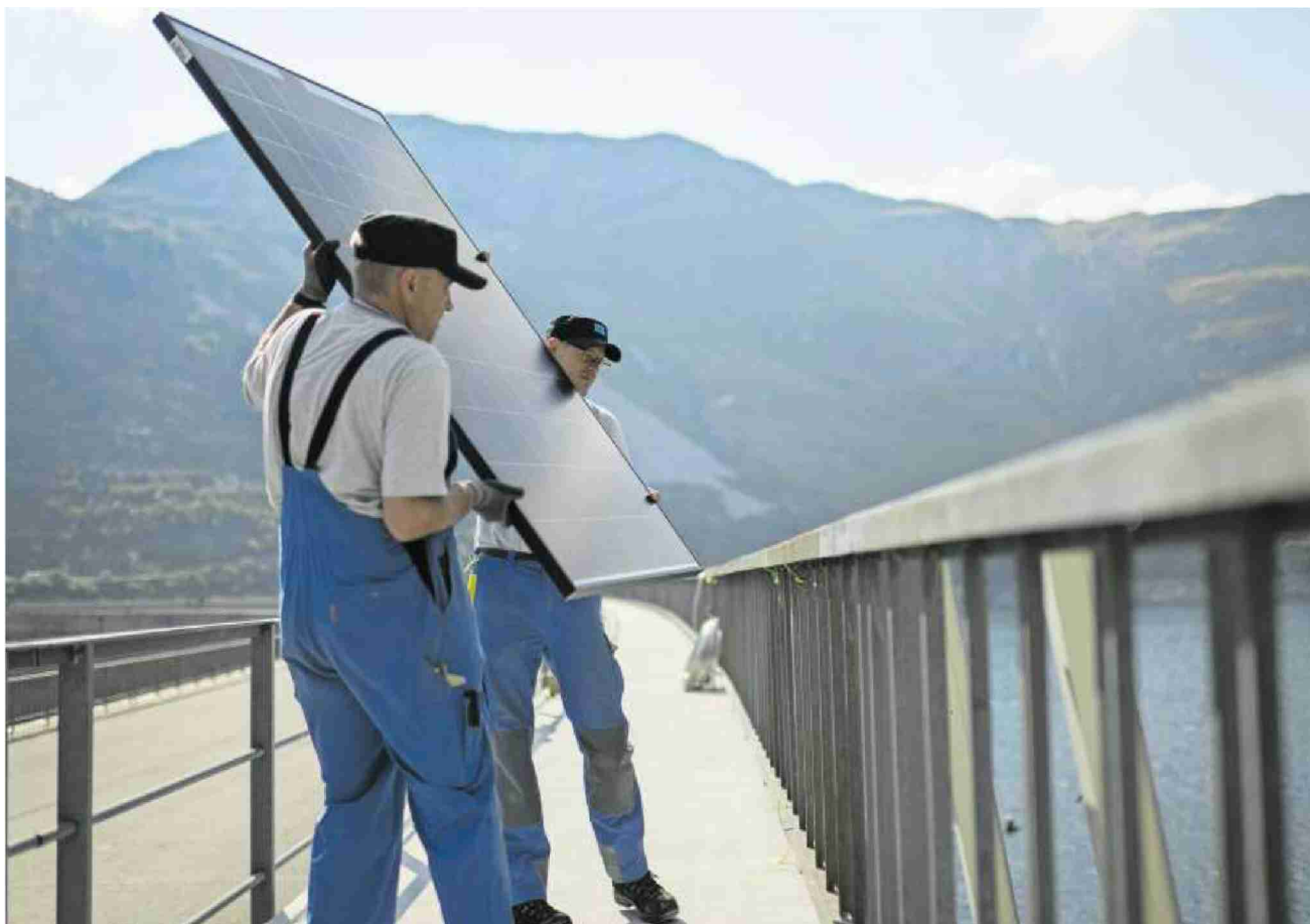
An der Staumauer des Lago di Lei im Val Ferrera sind im vergangenen August Solarpanels installiert worden. GIAN EHRENZELLER / KEYSTONE
