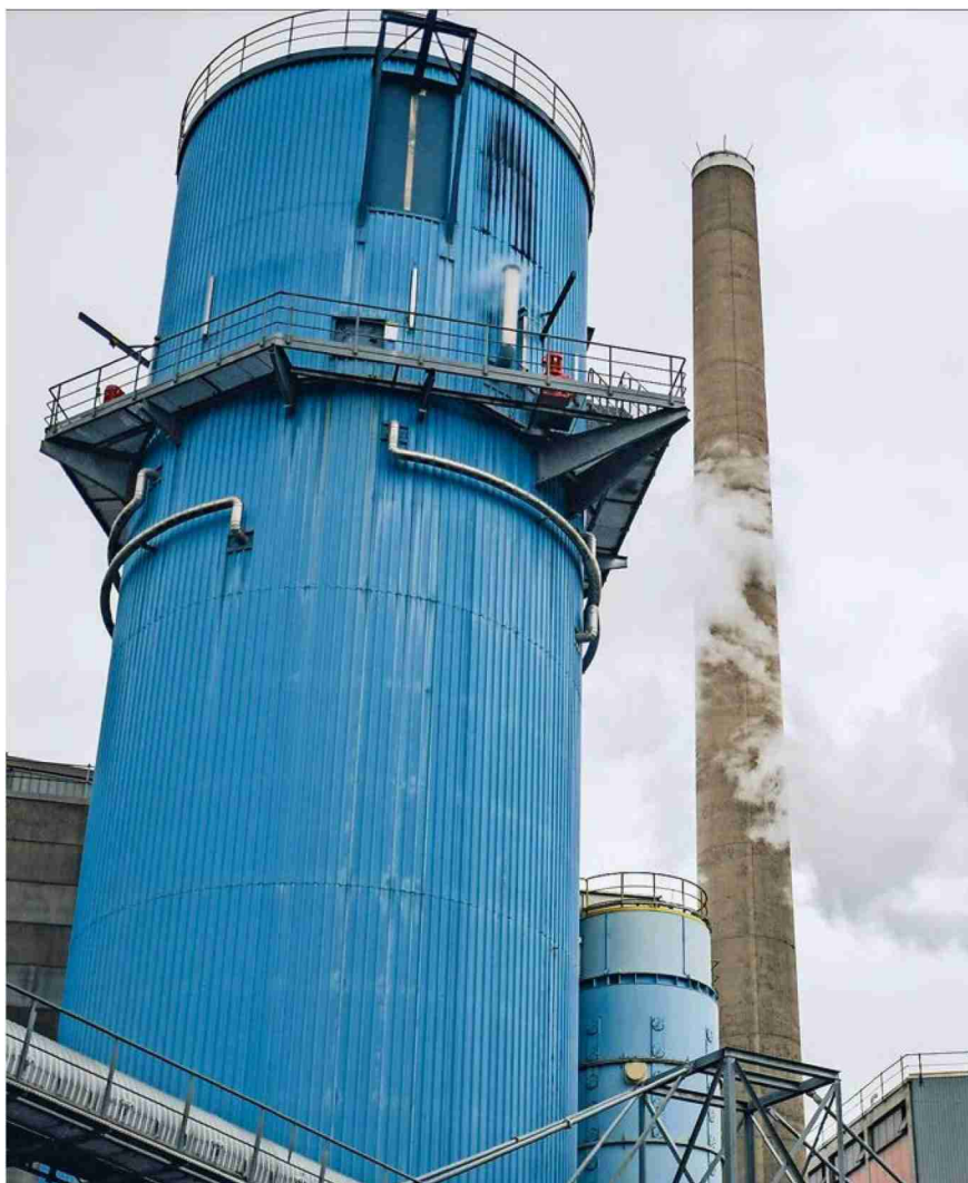
Im Extraktionsturm entsteht der zuckerhaltige Dünnsaft.
